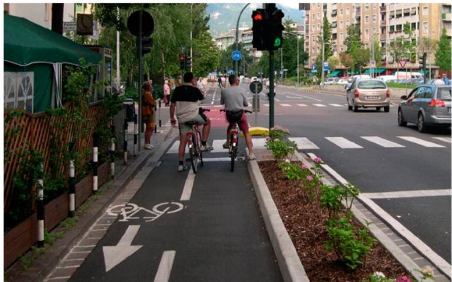
*Esempio di realizzazione di pista ciclabile in sede propria separata dalla carreggiata destinata ai veicoli a motore da uno spartitraffico fisicamente invalicabile della larghezza di metri 0,50*
