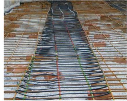
*Esempio di psizionamento di cavi scaldanti su rampe di accesso*
